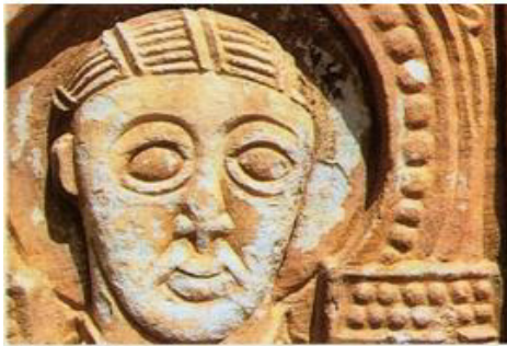
Şekil 3. Mikroorganizmaların sebep olduğu yüzeysel çözünmeler ve pul pul dökülmeler (1)
