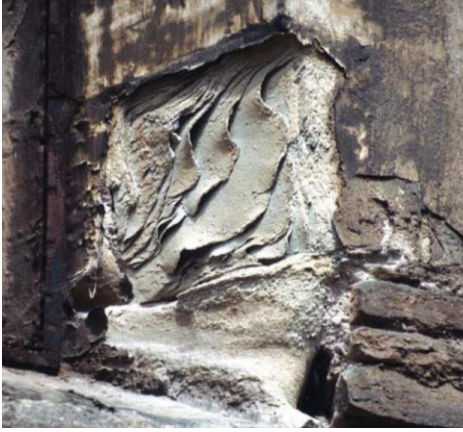
Şekil 1. Kumtaşında görülen, katmanların yaprağımsı toz halinde parçalanması (5)
