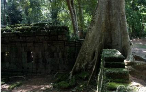
Şekil 9. Ağaç köklerinin kayanın içlerine kadar dallanmış olması (26)
