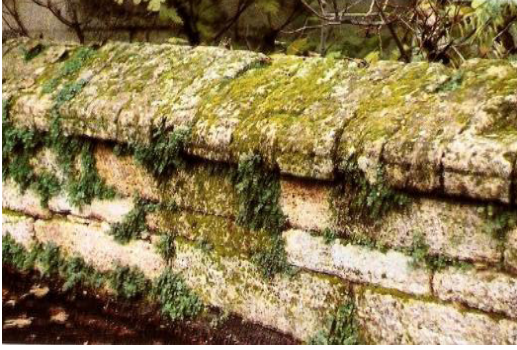
Şekil 5. Edirne Bayezit Camii kalkerli bahçe duvarı üzerinde nem oranının yükseldiği kış aylarında ortaya çıkan, yazın uykuda kalan liken ve karayosunların oluşturduğu alterasyonlar (1)
