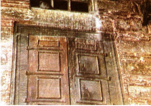
Şekil 10. İstanbul/Yeni Cami/ Hünkar Kasrı cephesinde güvercin dışkılarının neden olduğu kirlilik, taş çözünmeleri ve bozunma şeklinde görülen alterasyonlar (1)
